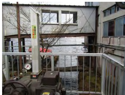
<長野堰榛名湖水門>
