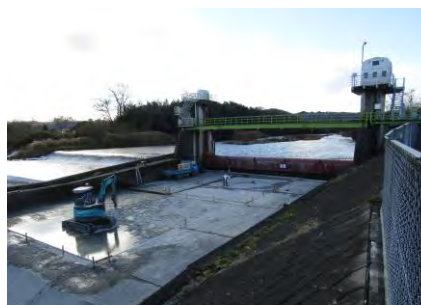
<長野堰頭首工（烏川）>
