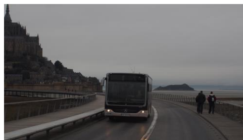
<新たに建設された橋の上を走るシャトルバス>
